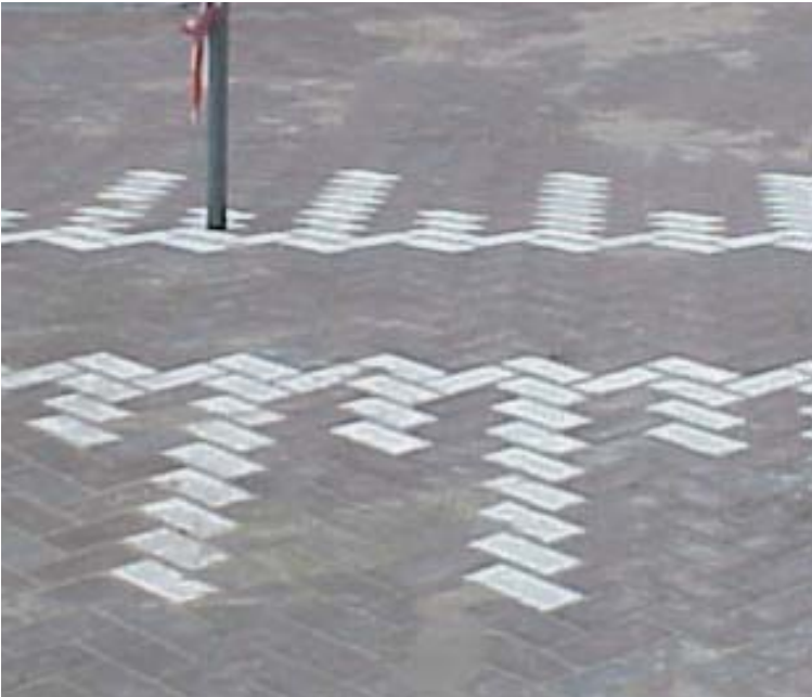
drempelmarkering in straat in verband van de verharding
