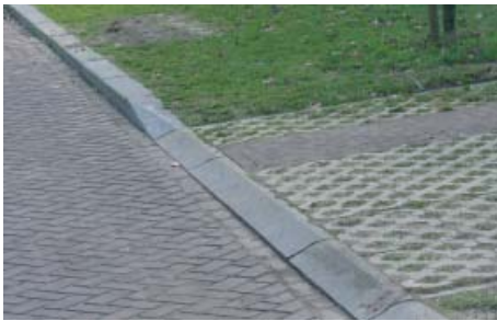
schuine banden 5/20 bij inritten hardsteenkleurig
