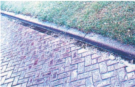
hoge trottoirband 18/20 langs rijwegen hardsteenkleurig
