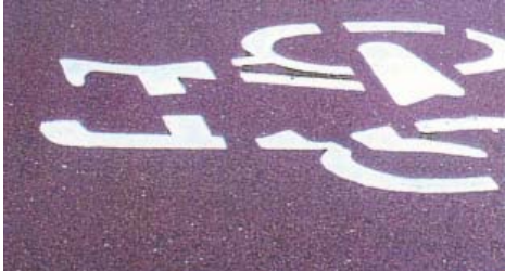
rood asfalt voor de fietspaden
